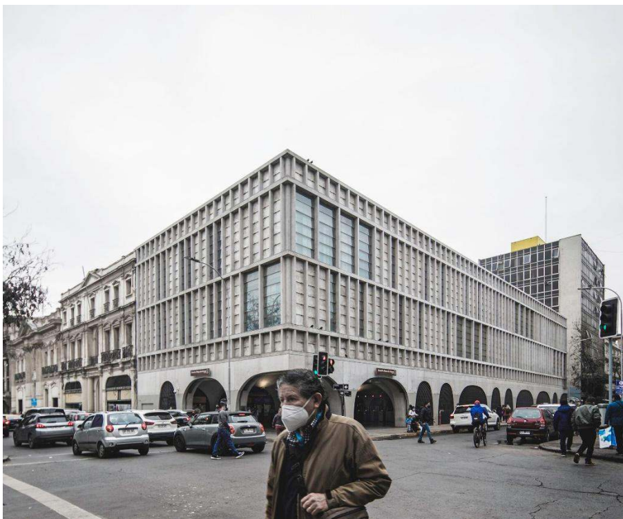
Edificio Estación Metro Plaza de Armas Santiago – Chile
